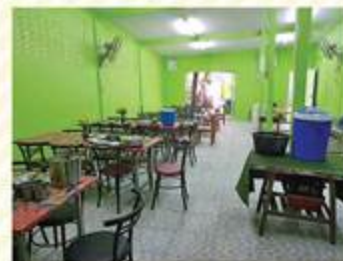
排水溝を移動し、床を埋め立ててタイル張りに。
