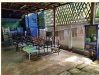
隣の建物との間にある排水溝の位置から内側をブロック壁で仕切っている。
