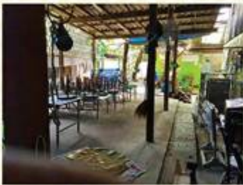
大雨になると食堂の床を横切る排水溝から水が溢れることもあり、常に湿気を帯びていたコンクリートの床。
