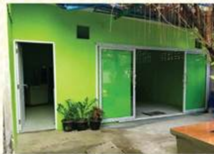
改修後の食堂の出入口。
