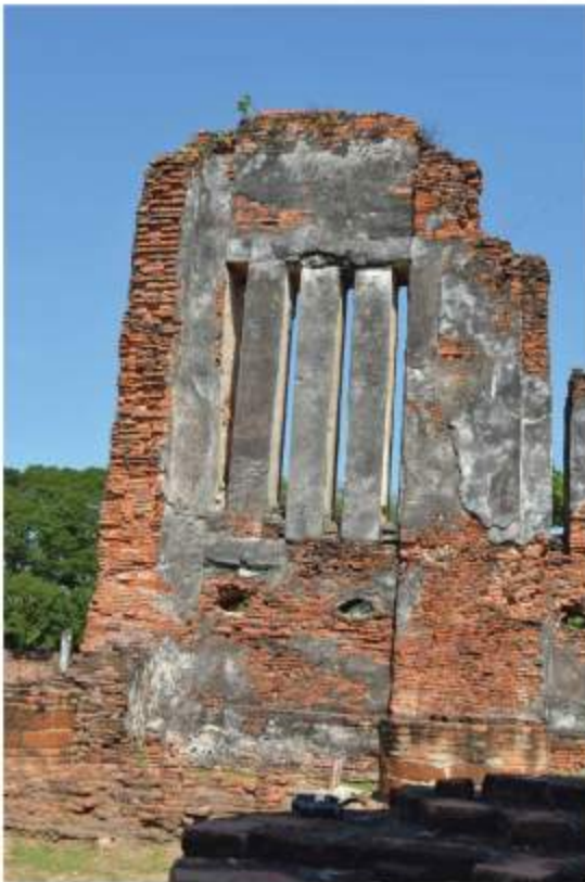
【写真2】スリットの入った壁
