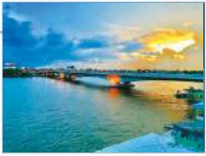
ベトナム道路間、本線延長(約 施工：(南北第1工区)大林組、 nunt Construction、 北第3工区鹿島建設、東急建設、
