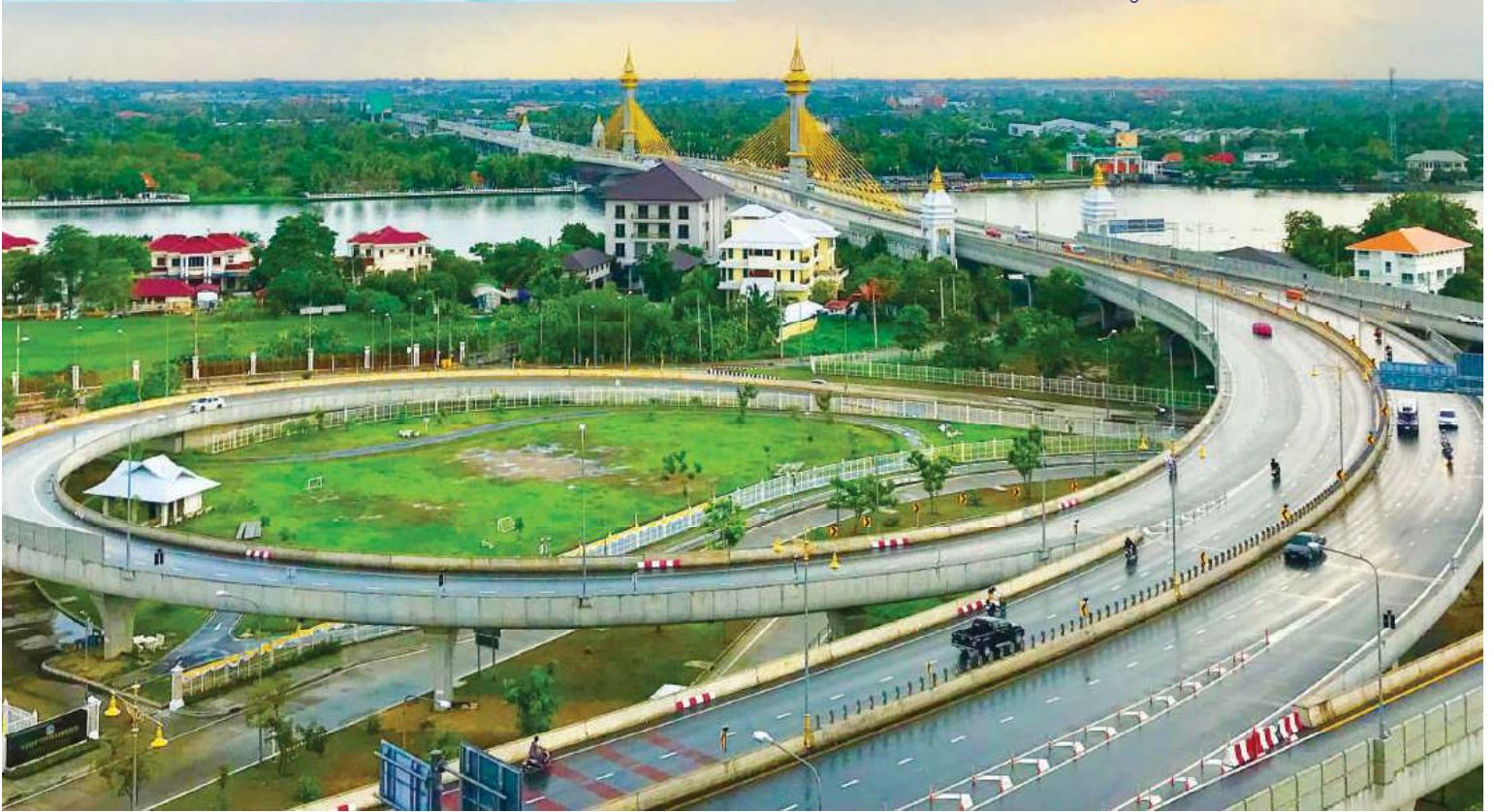
2014年12月に開通したノントブリ1道路橋
