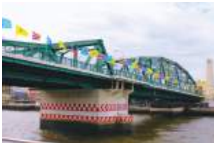
⑦メモリアル橋 第7次円借款(1980年 約42億円) 補修工事: 1983年11月~1984年12月 橋の長さ: 234m 着工: 1929年12月 開通: 1932年4月 古くからある鉄橋を末長く活用できるように、橋を支えているコンクリートの部分の基礎固めと橋桁の補修をODAで。
