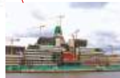
建設中の新国会議事堂
