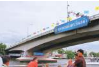
⑥ブラ・ピンクラオ橋 第1次円借款(1971年 約13億円) 橋の長さ: 280m 着工: 1971年8月 開通: 1973年9月 日本のODA事業としてタイで初めて建設された記念すべき橋であり、タイ初のコンクリート橋。人と物を地域を繋ぐ役割を担って46年。現役で活躍中。
