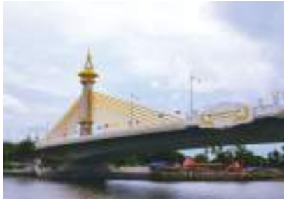
③ノントブリ1道路橋 第32次円借款(2010年 約73億円) 橋の長さ: 460m 着工: 2012年5月 開通: 2014年12月 ODAによってタイに建設された最後の橋。東南アジア初のエクストラドーズド(工法)橋。主塔の高さを斜張橋よりも低くできることからコスト削減にも。
