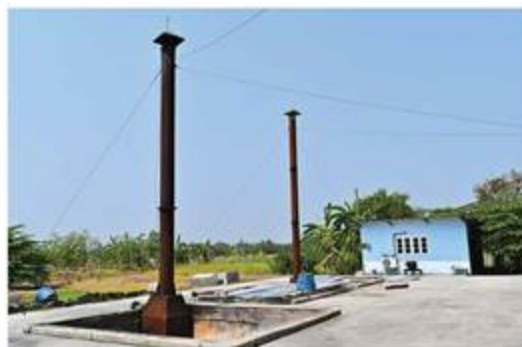
ナコンチャイシーに建設した工場(ナコンパトム県)
